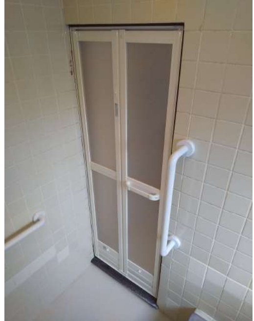
(施工後 閉めた場合)
